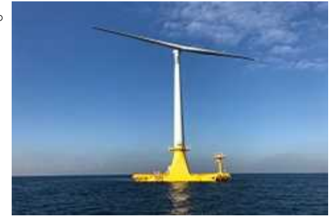
写真出典：次世代浮体式洋上風力発電システム実証研究(NEDO)
